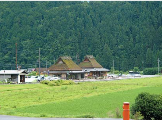
国道を挟んだ向かいの駐車場内に「かやの里」と「きたむら」が建つ
