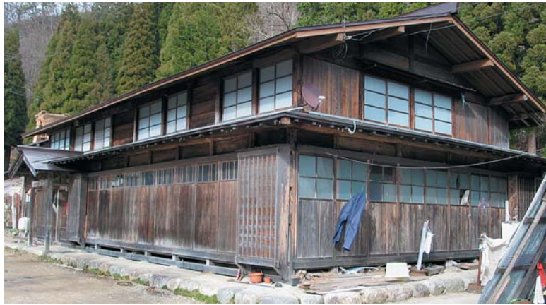
修理後の渡辺家住宅
