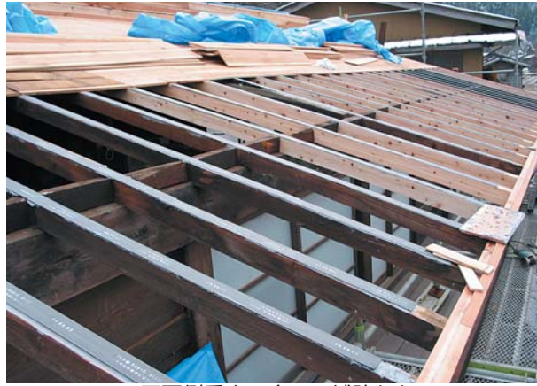
正面側垂木の全てに補強した
